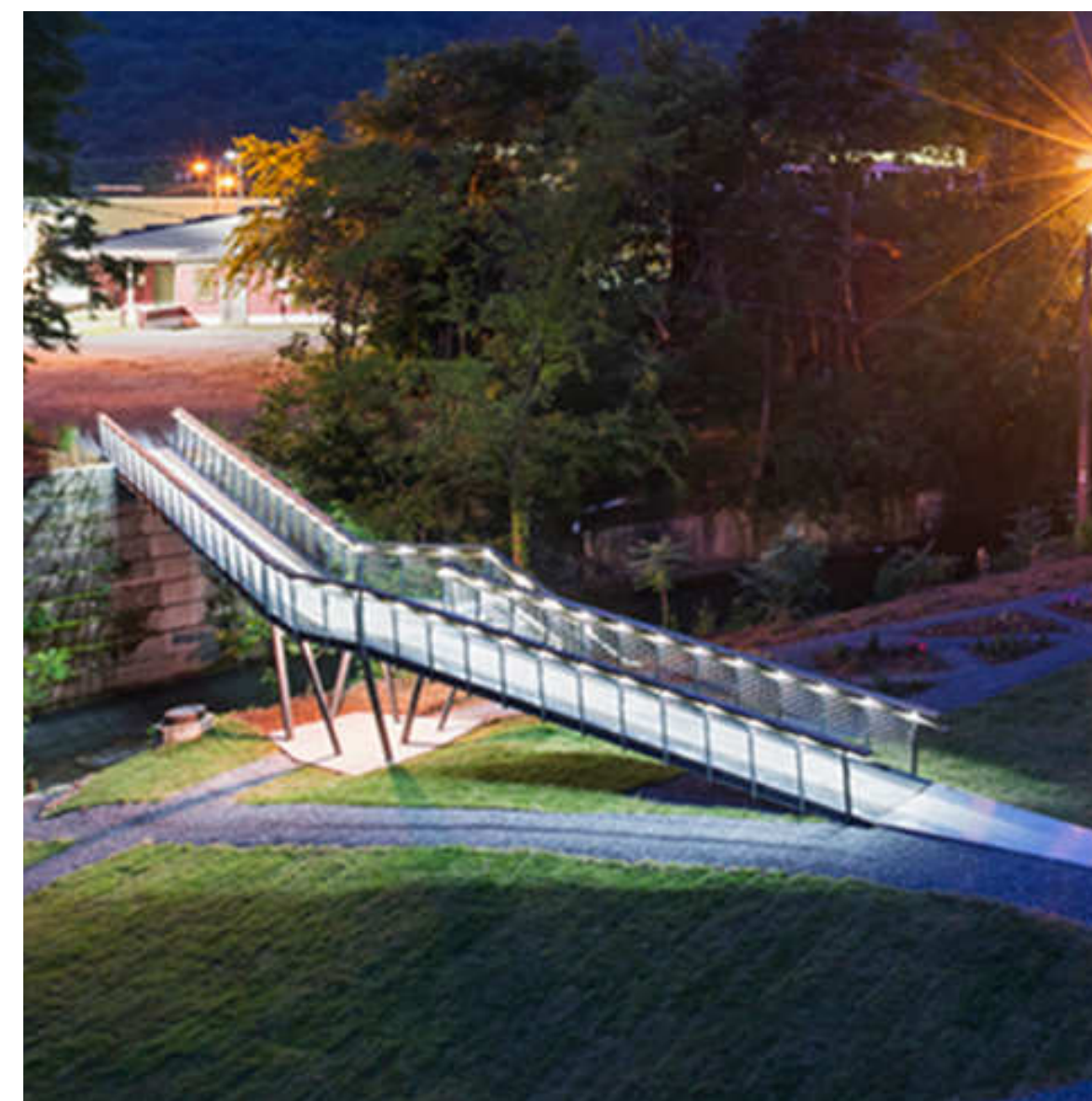
Пешеходный мост Smith Creek Авторы: buildLAB США 2013
