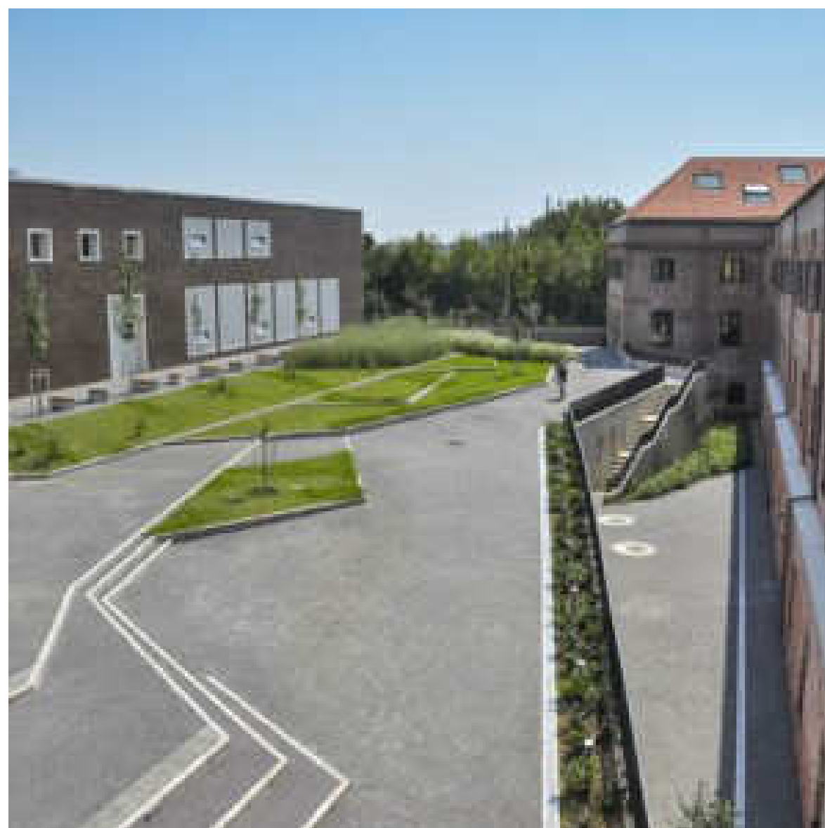
Модернизация завода Жолнаи — ландшафтный дизайн Южных территорий Ландшафтники: Ujirany / Новые Направления Ландшафтных Архитекторов (архитекторы Арпад Ковач Каталин Лукач, Габор Шорь, Доротья Торнэй, Доминика Тихарями) Архитекторы: MCXVI architects Печ, Венгрия проектирование - 2009, строительство - 2011 Площадь территории — 0,53 га Заказчик: Муниципалитет
