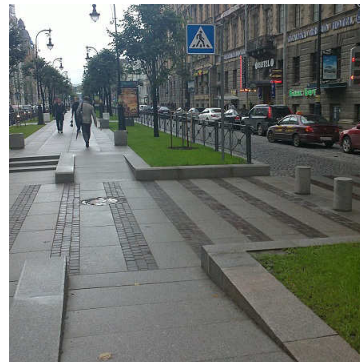
Реконструкция Большой Конюшенной улицы Санкт-Петербург, Россия 2010-2011
